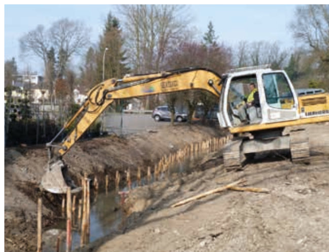
MARS - Travaux du Breyelgraben
