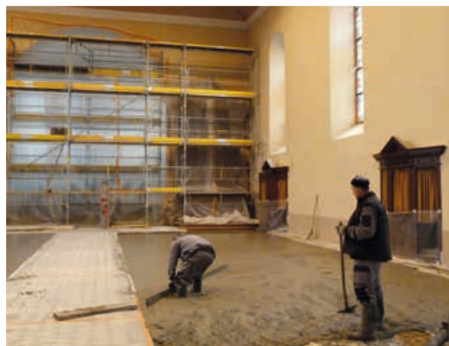
NOVEMBRE - Nouvelle chape
