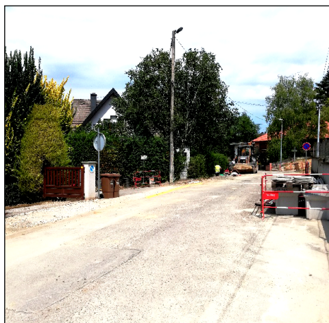
Travaux Rue du bourg
