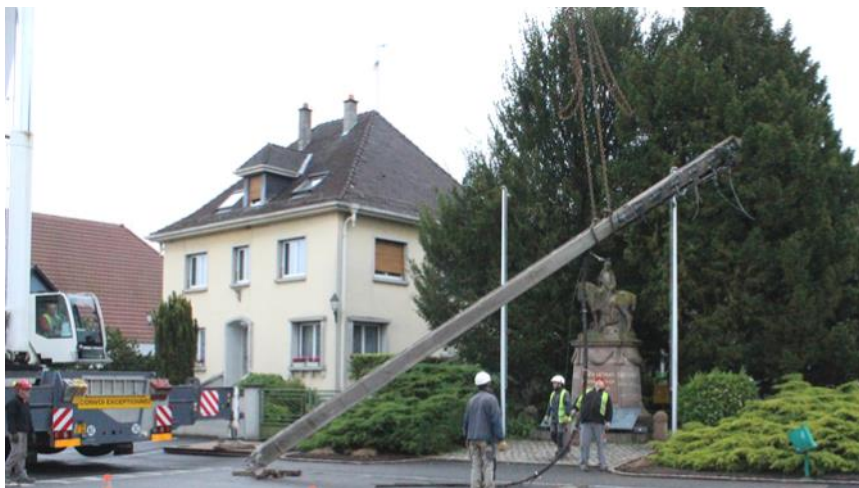
Dépose, à l'aide d'une grue, du dernier poteau béton implanté à l'arrière du monument aux morts et du presbytère à ILLFURTH
