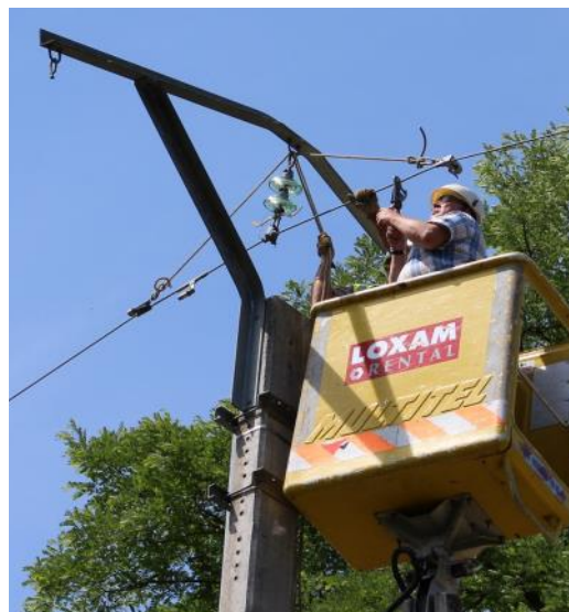
Dépose symbolique d'une portée de la ligne électrique moyenne tension à HIPPOLTSKIRCH
